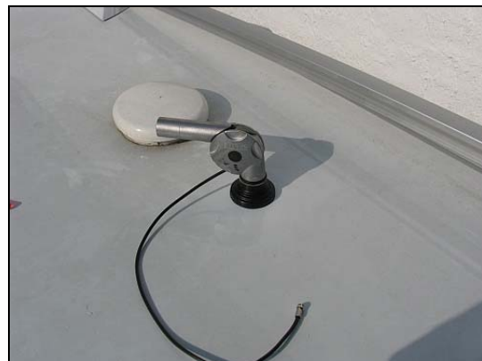
Abbildung 7: Antennenmast ist eingesetzt
