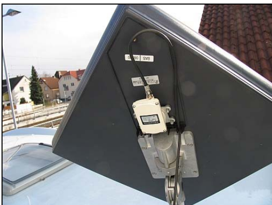
Abbildung 12: Anschluss an Antenne
