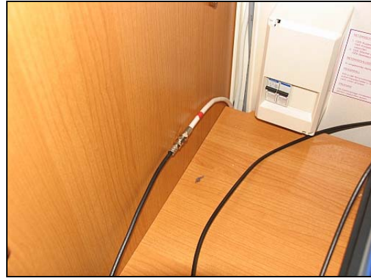
Abbildung 9: Anschluss an Antennenkabel
