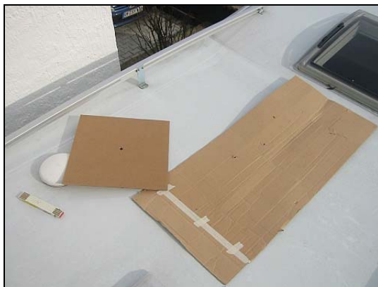
Abbildung 1: Suche nach Einbauplatz
